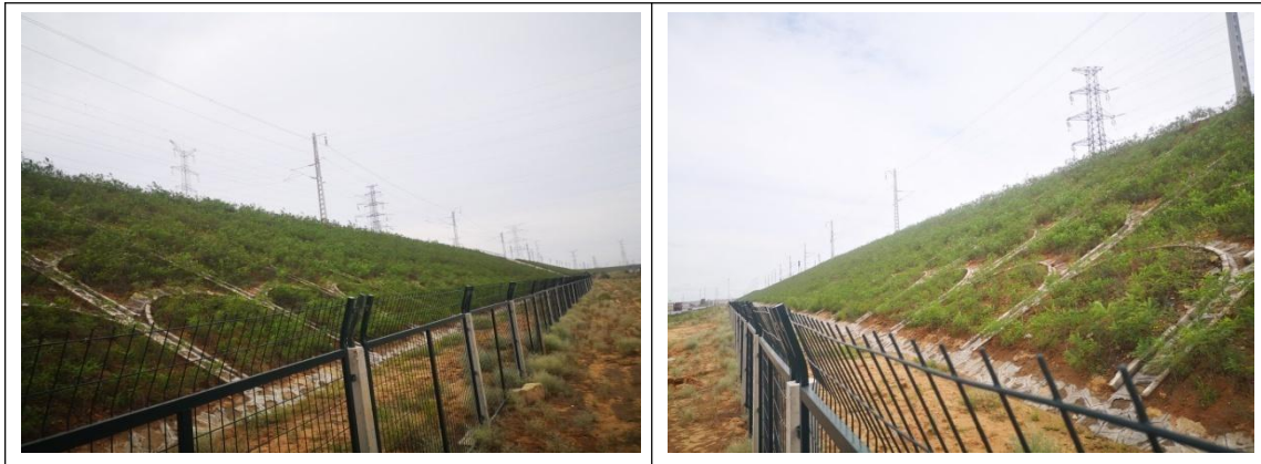
图 5.2-1 路基边坡防护工程
