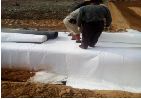
边坡土工布铺设焊接
