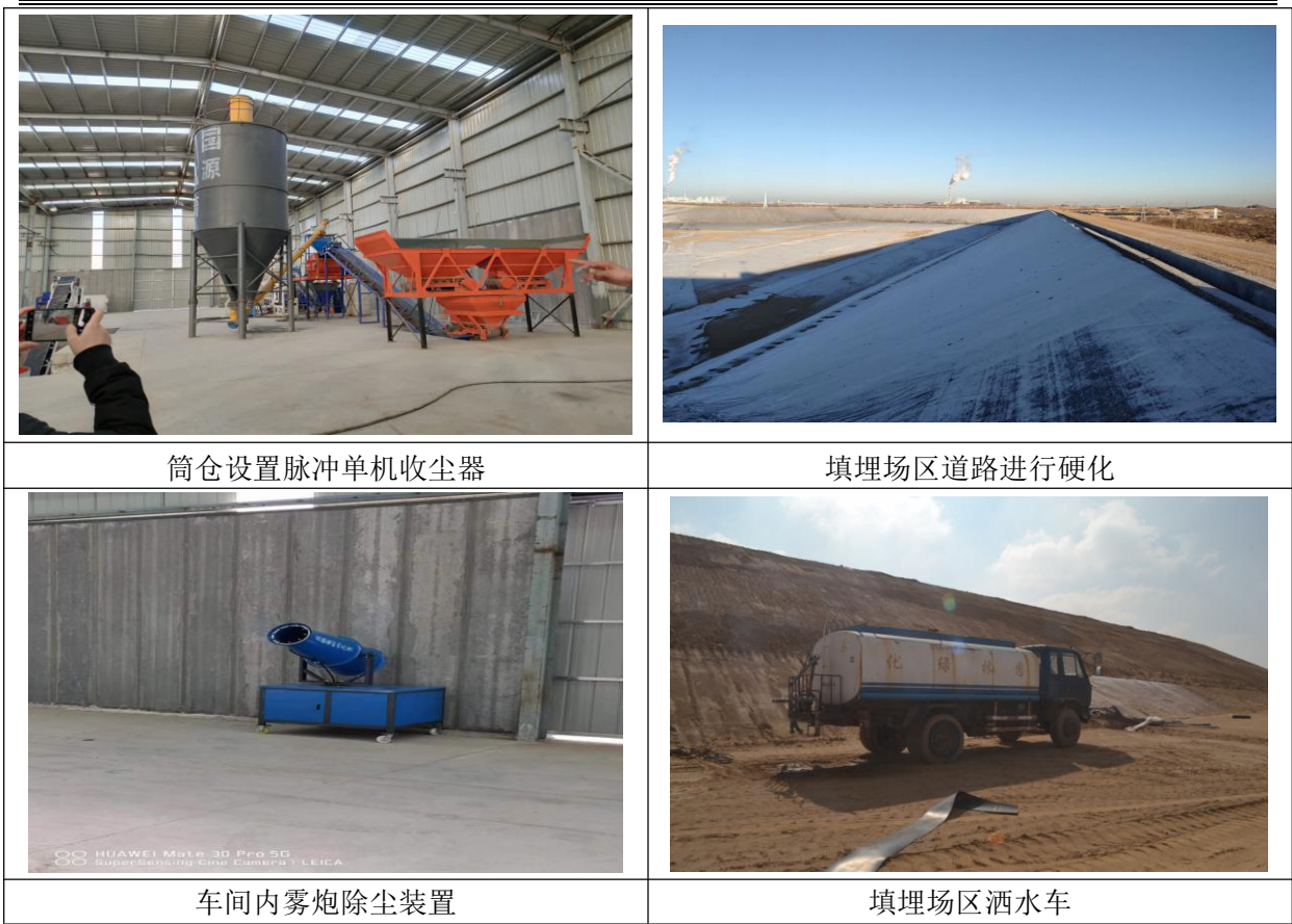
图 4-2 各废气治理设施照片
