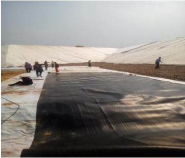
固废库底防渗施工
