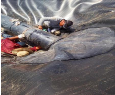
固废坝穿坝管与 DHPE 膜焊接施工
