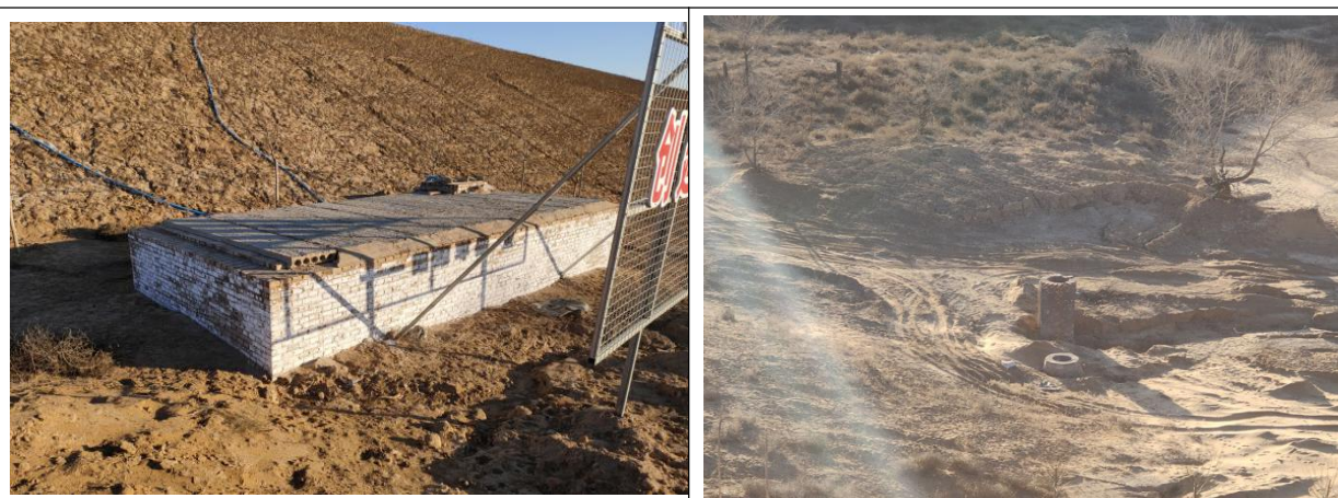
垃圾填埋场渗滤液收集池 ( 2 \times 50\text{m}^3 )
